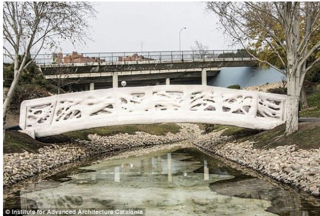
Figura 4. Puente construido mediante impresión 3D en Madrid
