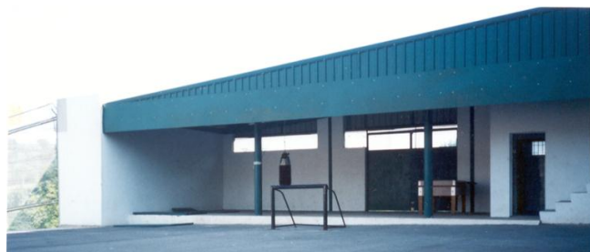
Foto 4.9: Cancha y visera del primer piso (patio trasero)
